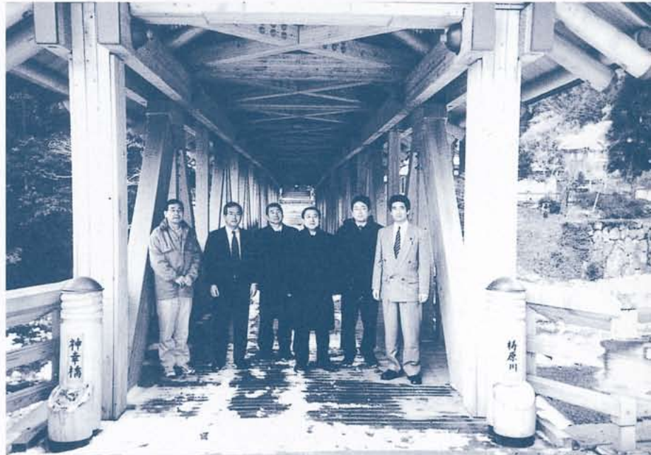
地域材による町道の木橋
