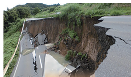
秋田市 雄和岩城線 後野地区 仮設迂回路設置状況
